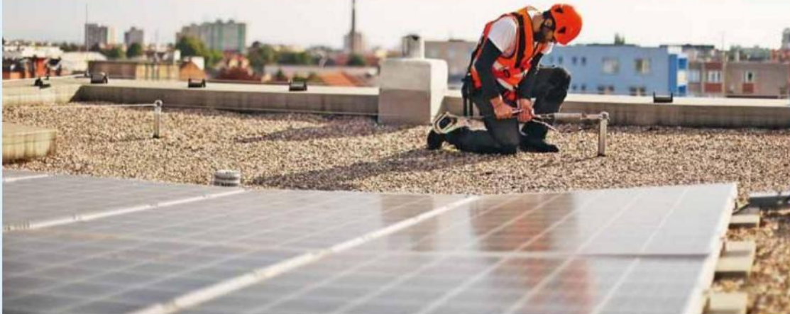
Pro bezpečnou instalaci a údržbu solárních panelů se vyplatí záchytný systém na střeše. Roofix
