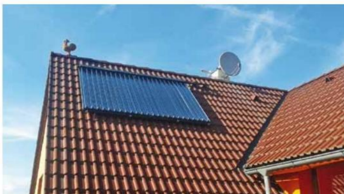
Pokud vám jde jen o ohřev vody, dobře poslouží termické solární kolektory. Vysokou účinnost nabízejí trubkové vakuové. Buderus
